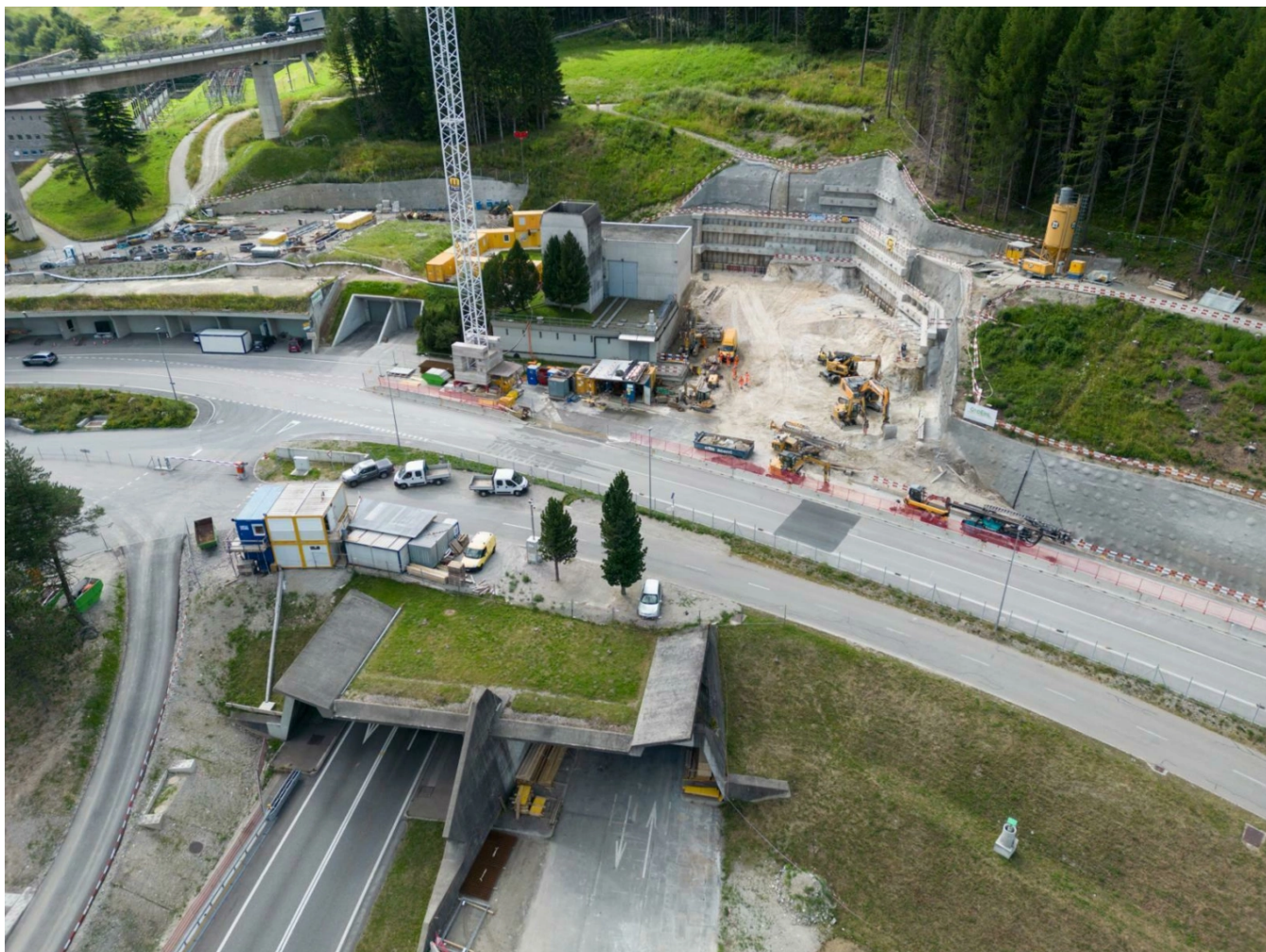
Die Baustelle für die zweite Röhre am Nordportal bei Göschenen. Foto: Gaetan Bally (Keystone)
